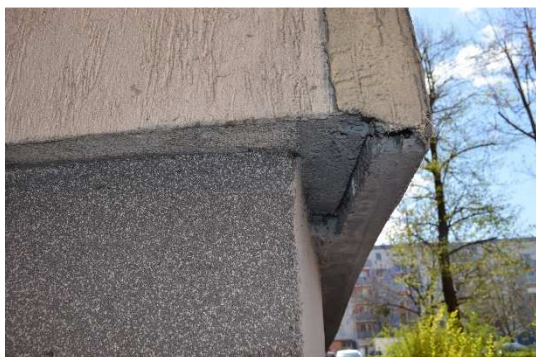
Docieplenie na styku cokołu z górną partią elewacji
