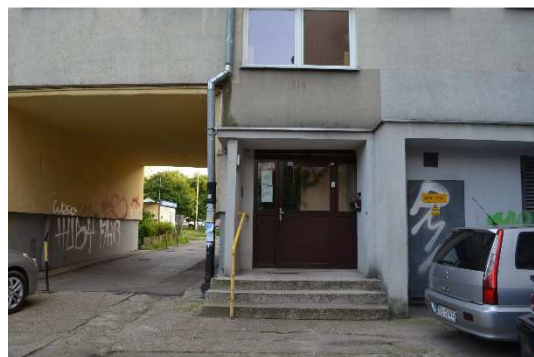
brama przejazdowa i wejściowa klatka nr 114
