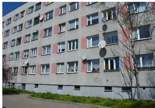
Elewacja południowa segment 120-122
