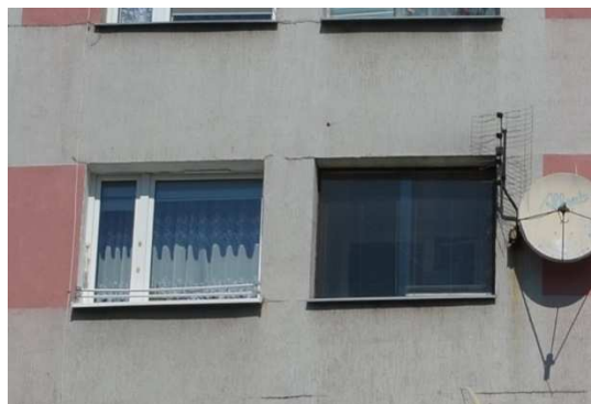
Wybrane spękania izolacji termicznej przy ościeżach okien
