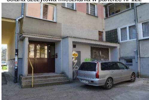
Wiatrołap i stacja trafo pod nr 114
