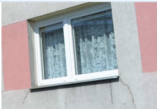
Wybrane spękania izolacji termicznej przy ościeżach okien
